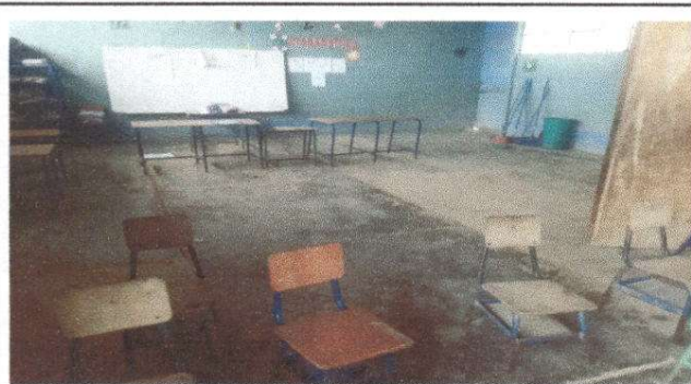
Foto1: Sustitución de piso de cemento liquido por piso cerámico.
